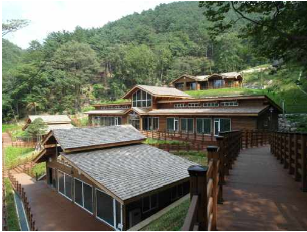
대관령 치유의 숲 시설(전경)
